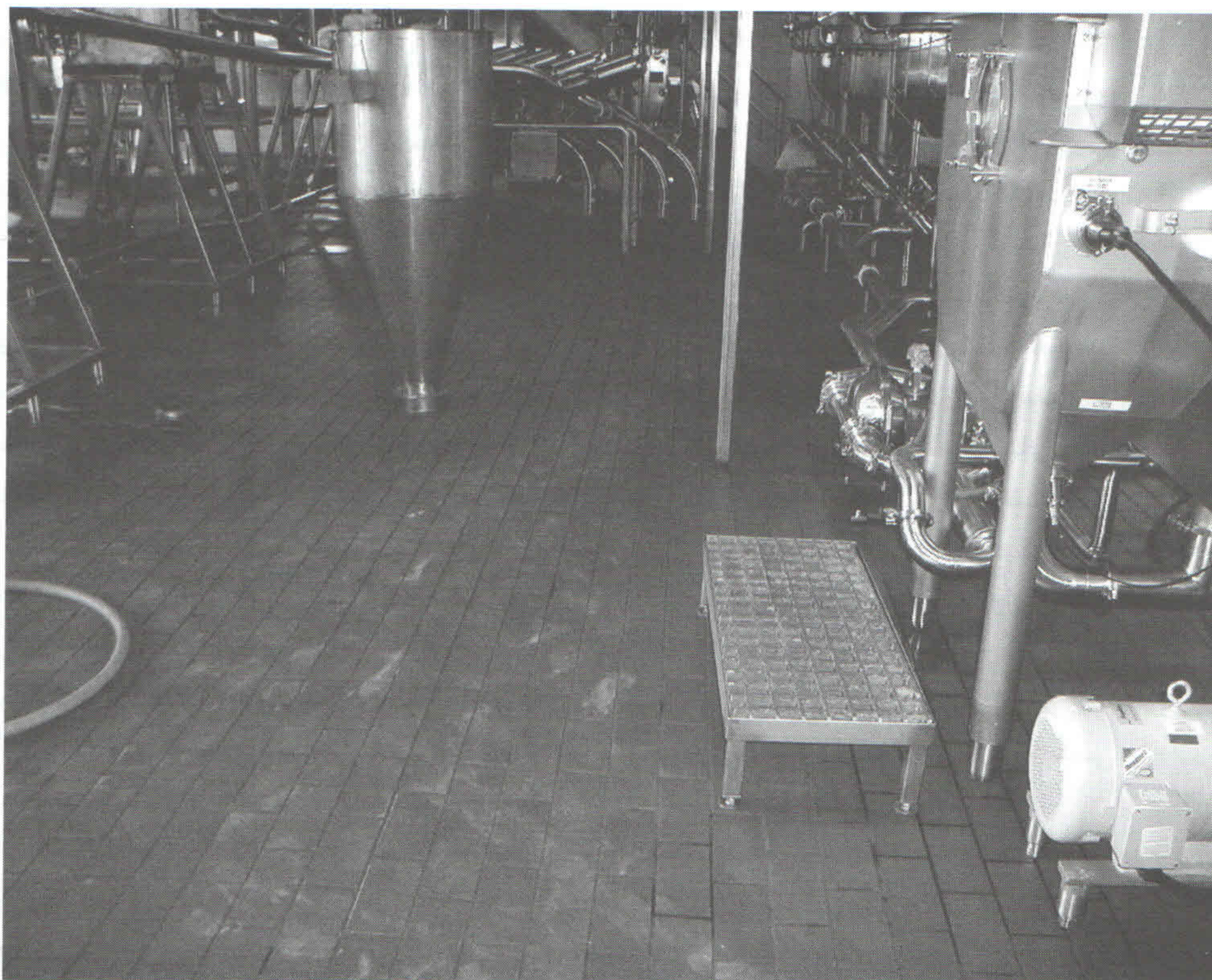
▲ کاشی کاری ضد اسید در کف سالن تولید لبنیات مودستو آمریکل
