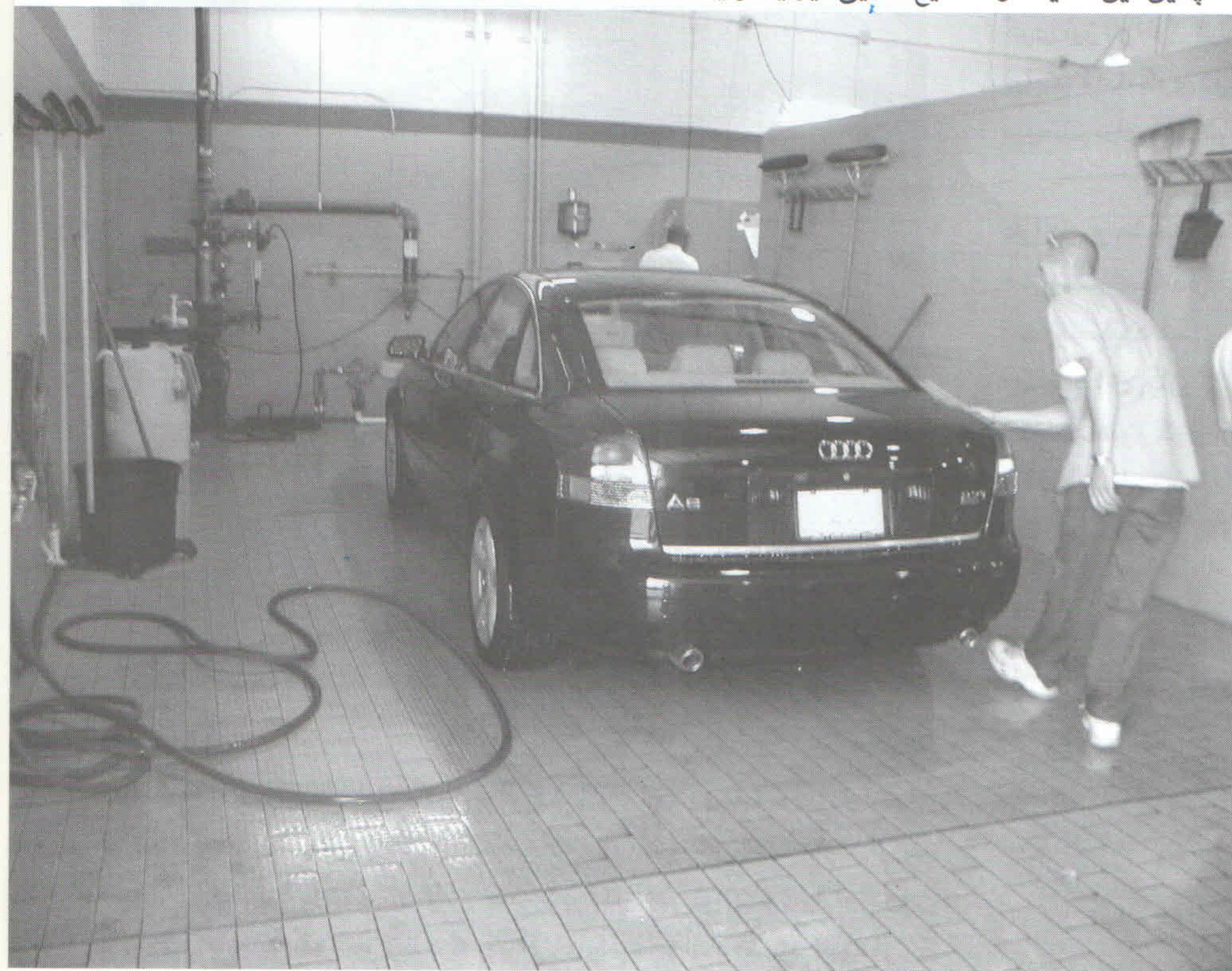
▲ کاشی‌کاری مقاوم به تنش‌ها و بارهای مکانیکی در کف تعمیرگاه اتومبیل در دیترویت آمریکا
